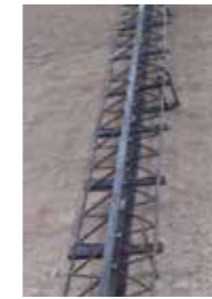
Antes do enchimento Antes del llenado
