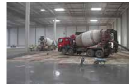
Obra com lajes em diversas etapas de construção Obra con losas en diferentes etapas de construcción
